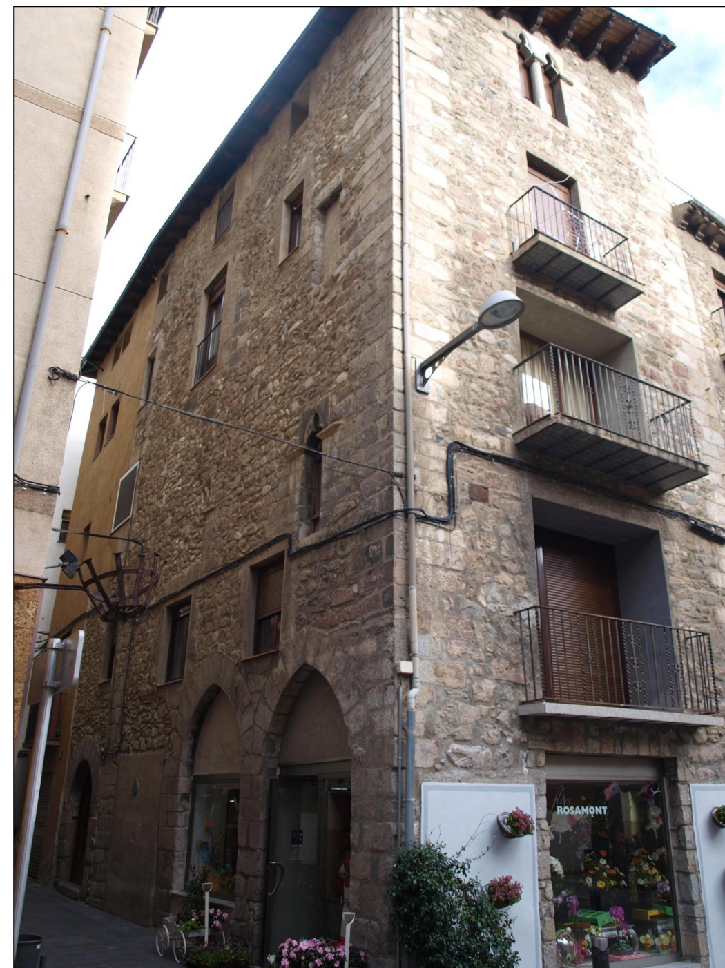
Fig. 24. Volumetria en forma de torre de l'immoble de Cal Serrano (Imatge pròpia)
