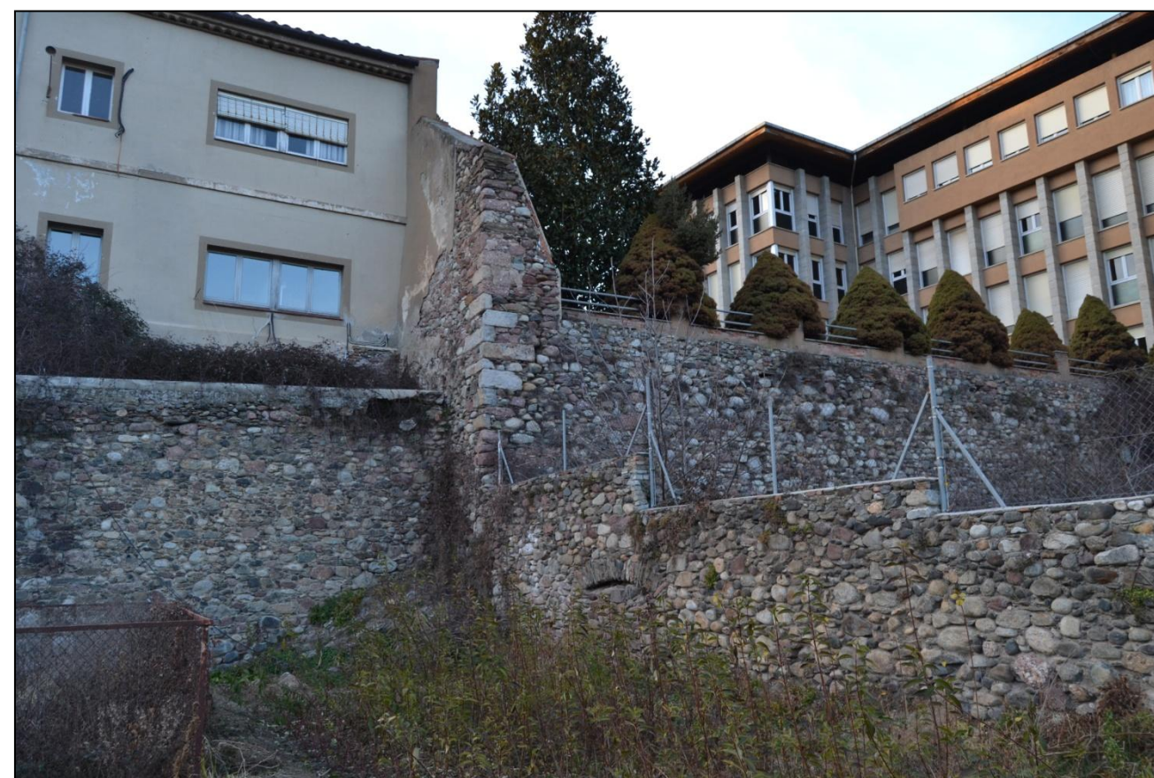
Fig. 76. Imatge de l'angle sud-est de la torre on hi ha el portal del Bisbe, amb els costats reforçats amb carreus de granit perfectament escairats (Imatge pròpia).
