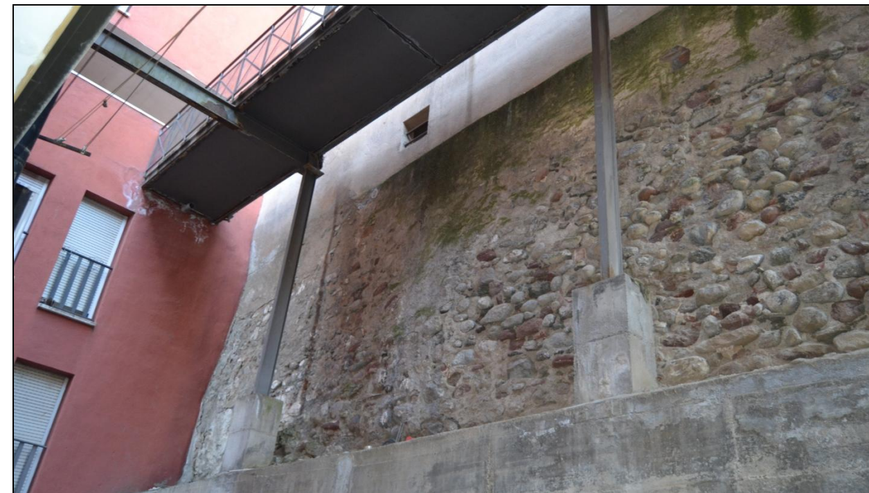
Fig. 52. Restes de la muralla a la part baixa de la façana de llevant de Cal Pacho. S'observa el lleuger talús que fa en la zona on hi ha la possible torre (Imatge pròpia)
