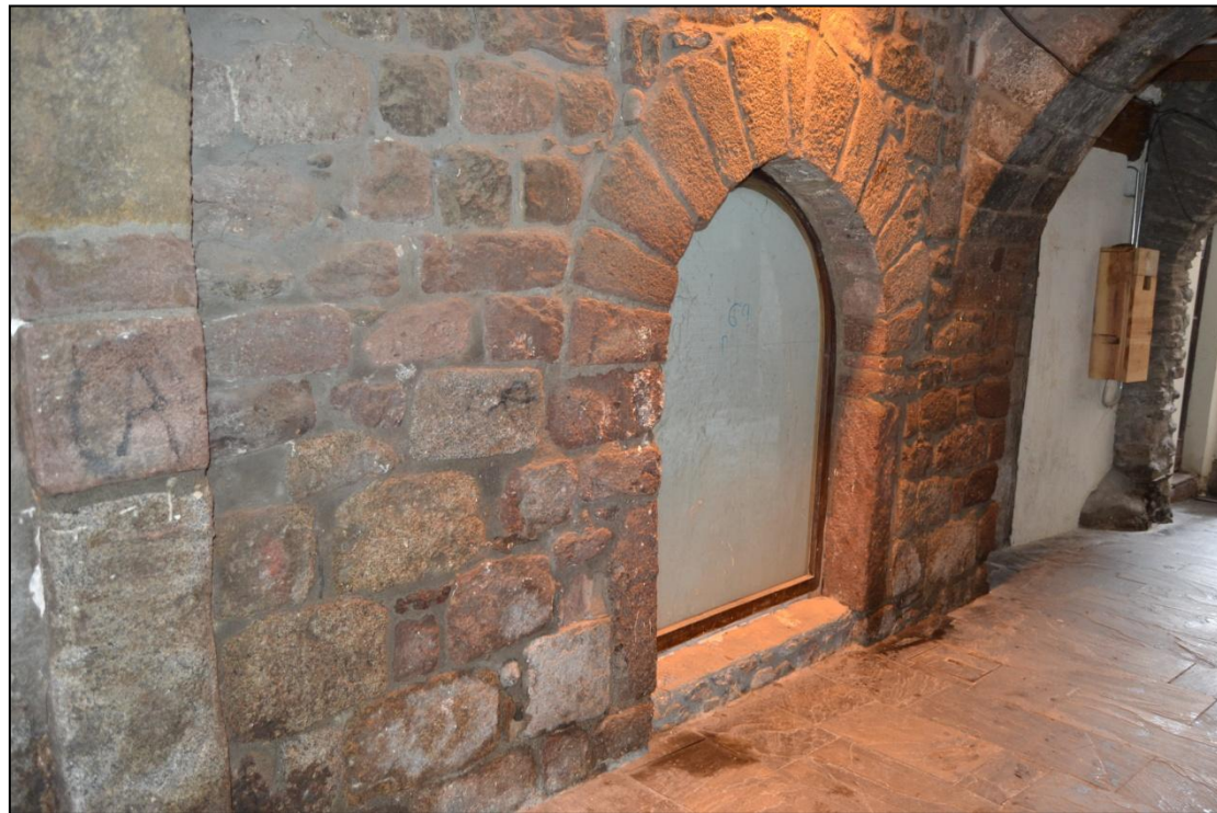
Fig. 11. Portalet interior del portal al costat est (Imatge pròpia)
