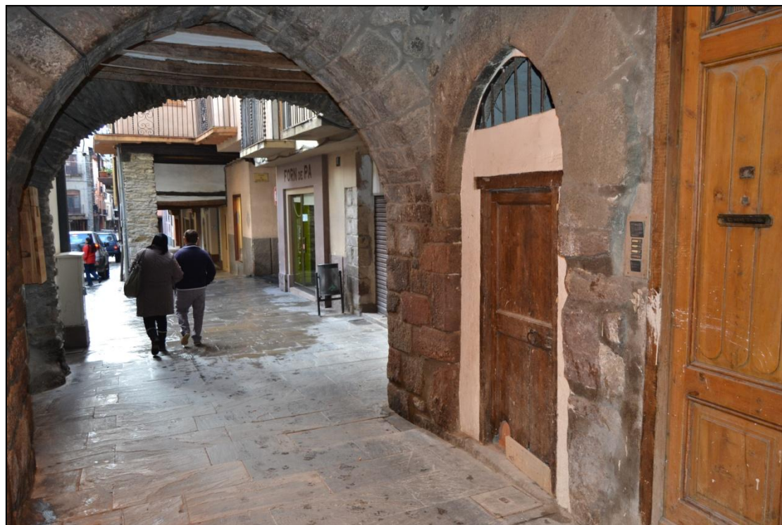
Fig. 12. Portalet interior del portal al costat oest (Imatge pròpia)
