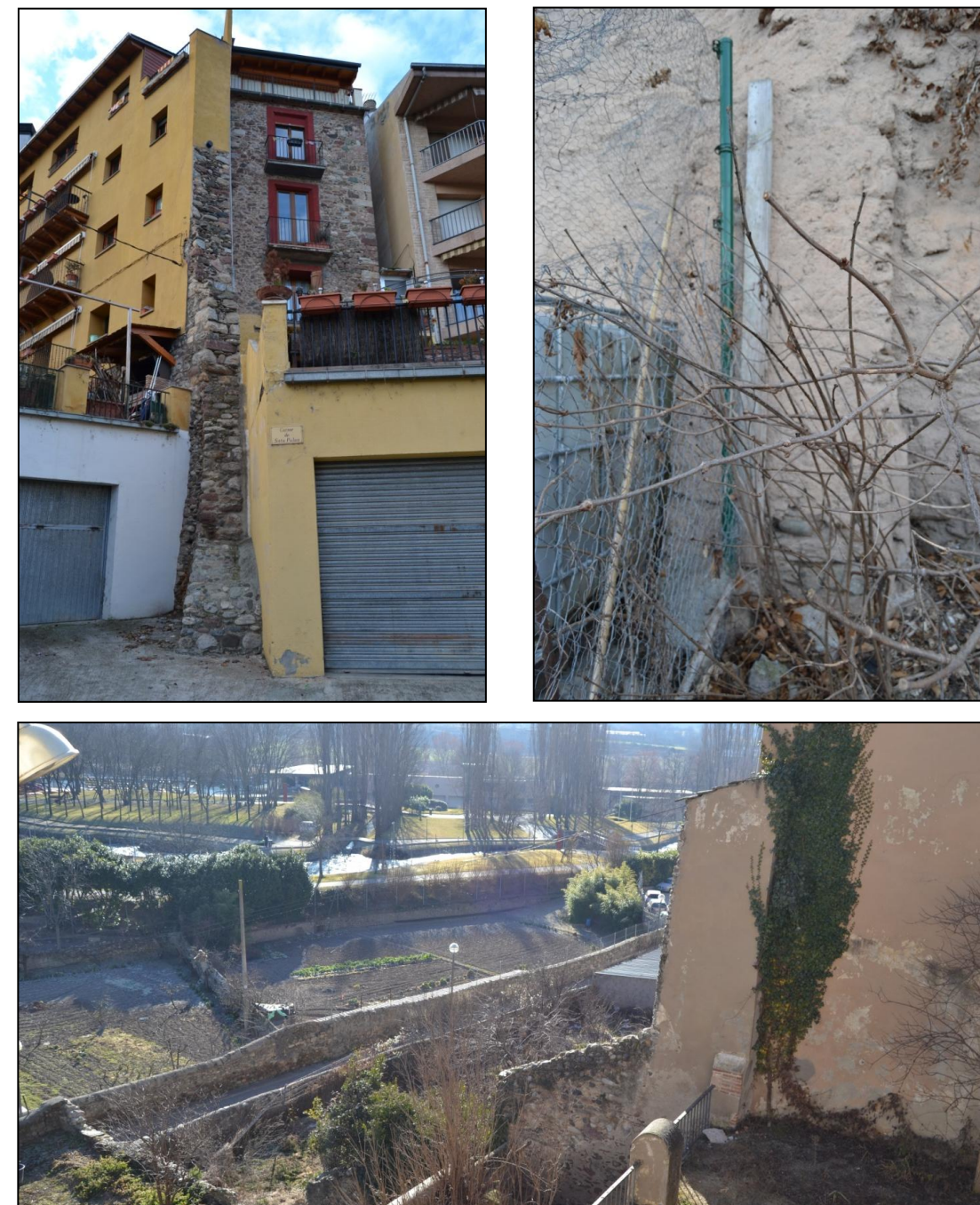
Fig. 59 a 61. Diverses restes localitzades a la façana de llevant que podrien correspondre a arrencades de bestorres desaparegudes: la primera a la Baixada del Molí; la segona en un tram central situat entre el pati de l'edifici dels antics jutjats i el basament encara conservat de la bestorre de l'antiga era de Cal Saire; la darrera imatge corresponent a l'angle sud-est del pati dels antics jutjats (Fotos pròpies).
