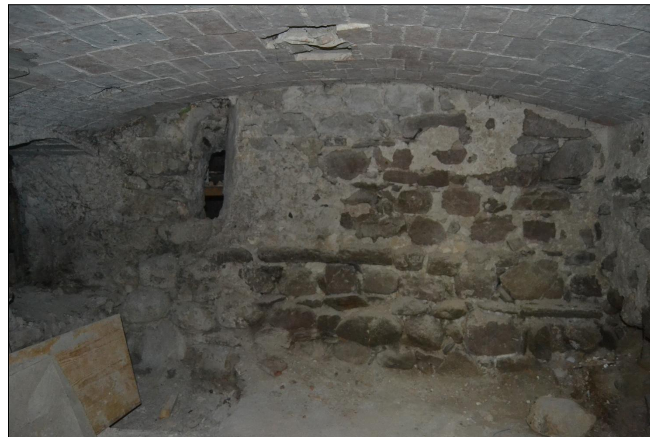
Fig. 18. Mur interior d'un dels àmbits del soterrani de Cal Cosp que podria correspondre amb una estructura amortitzada, amb la finestra espitllerada (Imatge pròpia).
