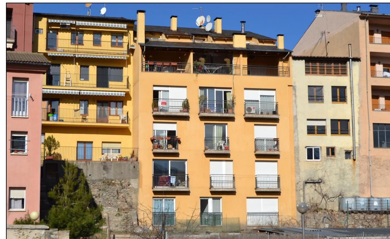
Fig. 50. Restes de la muralla en un petit pati a l'extrem esquerra de la imatge (Imatge pròpia)
